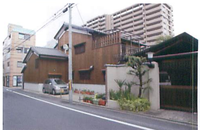
図 1c 整備後の景観
