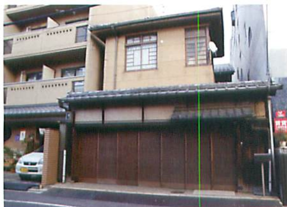
図 4a3a 整備前の景観
